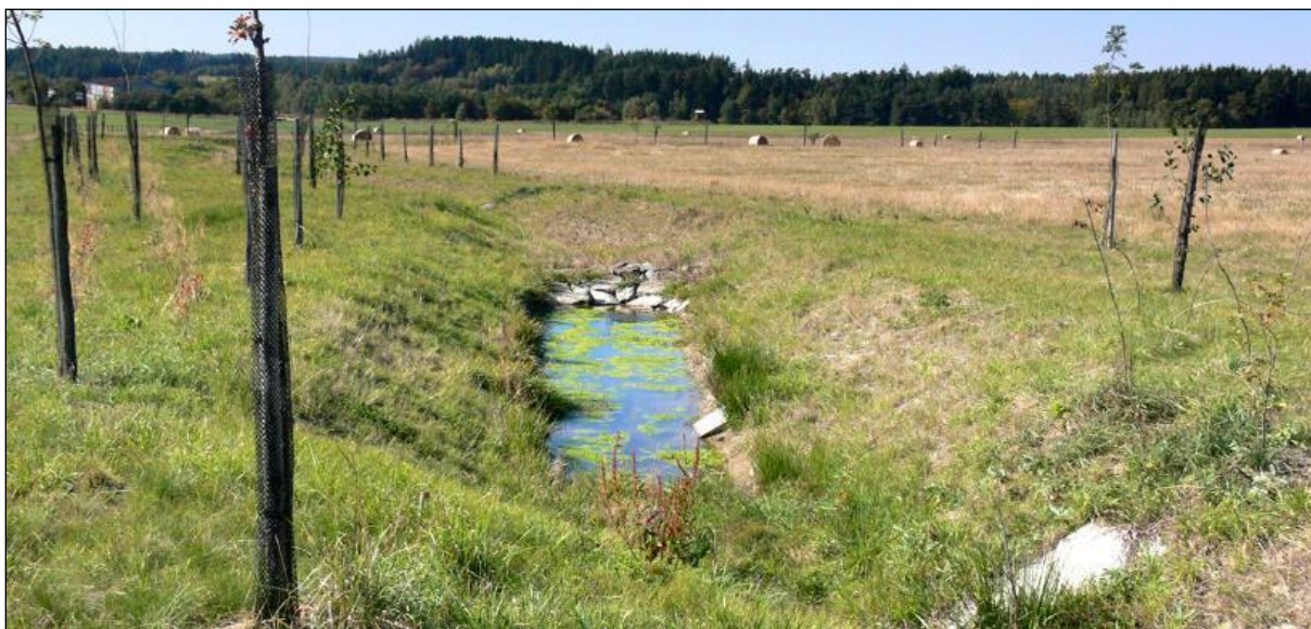
Revitalizovaná údolnice se zpevněním profilu, drobnými tůňkami a ozeleněním ve Skřípově (zdroj: P. Pavka)
