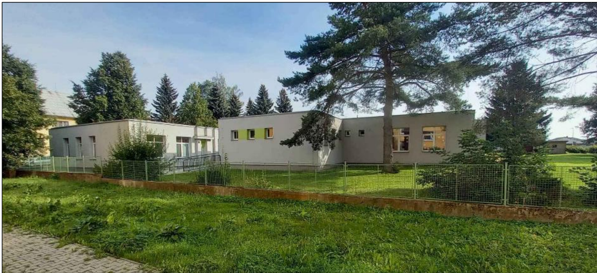
ZŠ a MŠ Praktická (Pardubický kraj) – objekt potenciálně vhodný pro realizaci FVE na střeše, zelenou střechu nebo akumulaci nádrží.
