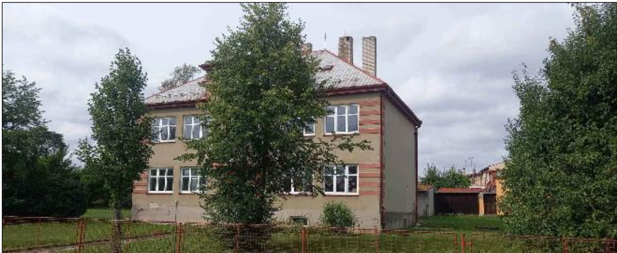
Dětský domov – předpoklad přestavby na bytový dům. Potenciál pro úspory energie a adaptační opatření
