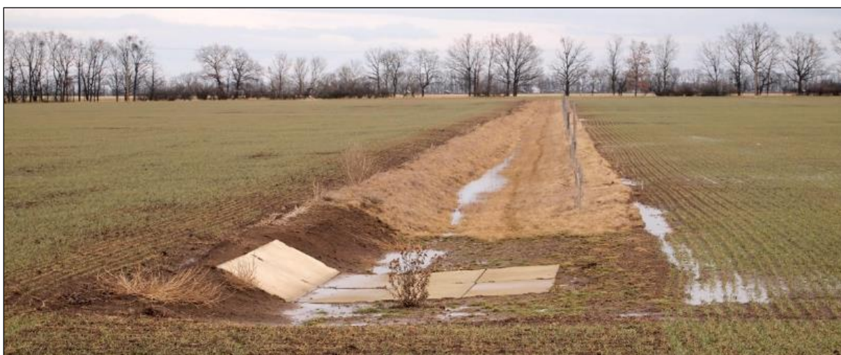
Zasakovací protierozní průleh s novou výsadbou v Banticích (zdroj: P. Pavka)
