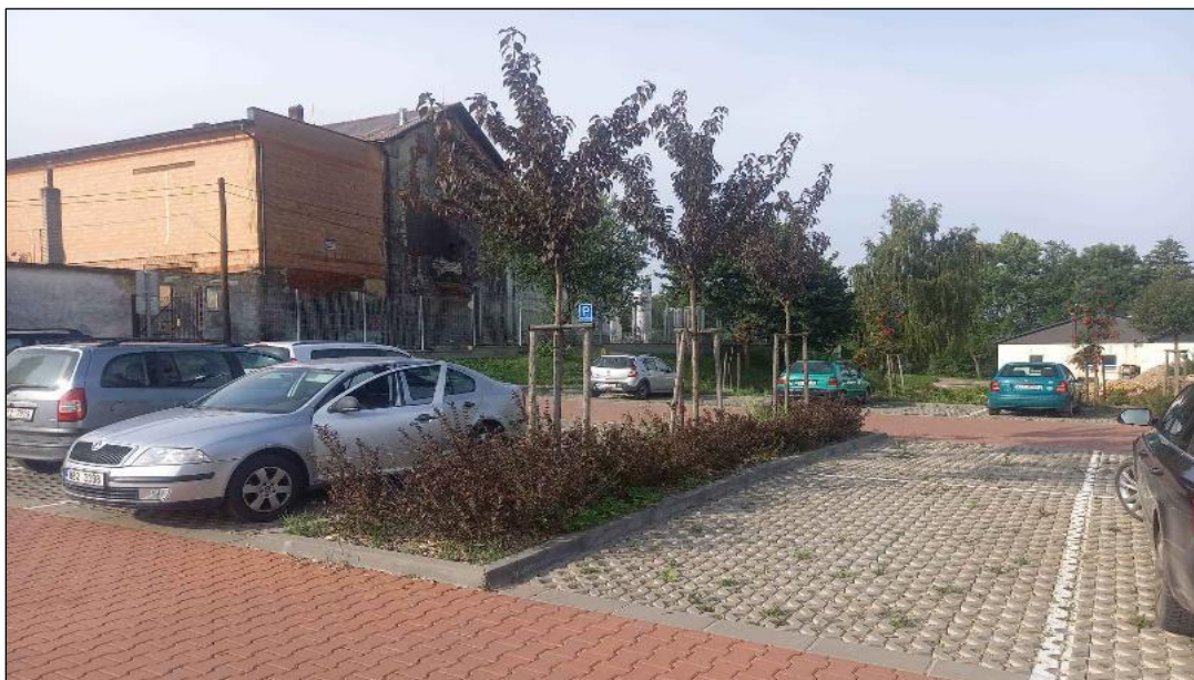
Využití polopropustných a propustných povrchů, květinových záhonů a dřevin na parkovišti – u Měšťanského pivovaru
