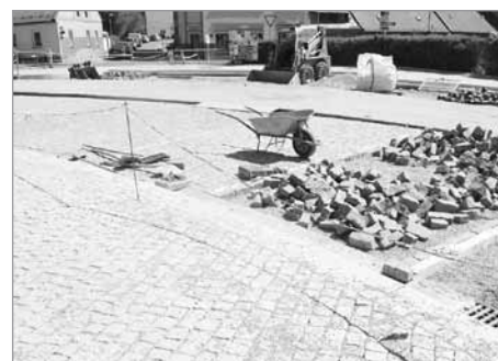
I v květnu pokračovaly intenzivně práce na Tyršově ulici
